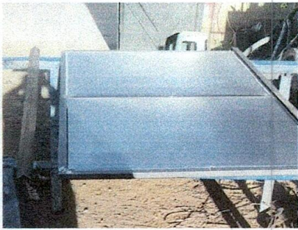
FOTO 3: SUSTITUCIÓN DE PUERTA PRINCIPAL DE METAL DE BAÑO CON CHAPA
