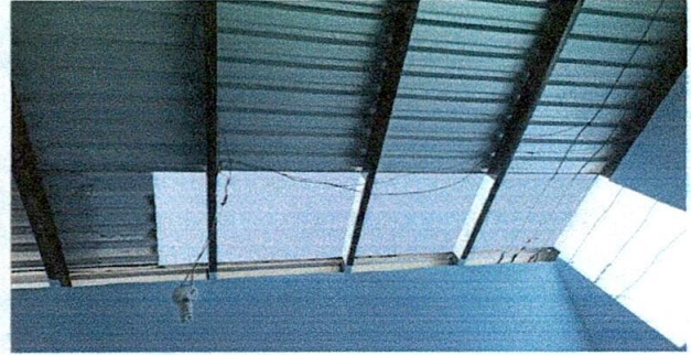
FOTO 2: SUSTITUCIÓN DE LÁMINA
