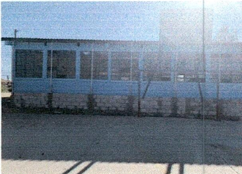
FOTO 15: REPARACIÓN DE MURO PERIMETRAL DE BLOCK CON TUBO HG Y MALLA GALVANIZADA, SOLERAS INTERMEDIAS Y COLUMNAS
