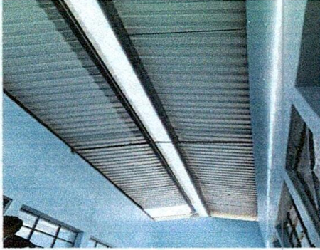
FOTO 1: SUSTITUCIÓN DE CAPOTE DE LÁMINA
